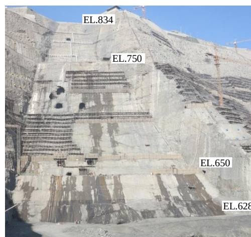
图 2 金沙江白鹤滩水电站左岸坝基 Fig.2 Left dam foundation of Baihetan hydropower station
